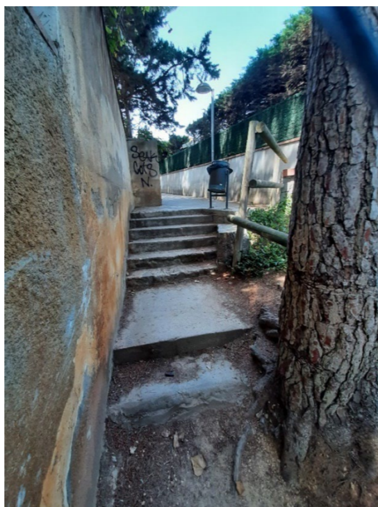
Fotografia estat actual, escales final carrer vianants a Camí de Ronda
