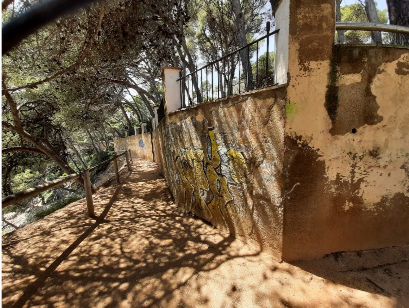
Fotografia estat actual Camí de ronda, amb parcela clau 11a
