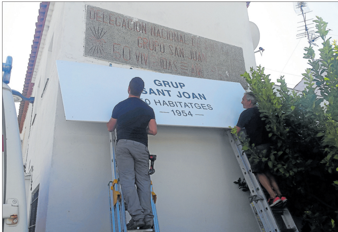
Operaris d'una empresa especialitzada realitzen la instal·lació del nou plafó damunt l'antiga placa. DdG
