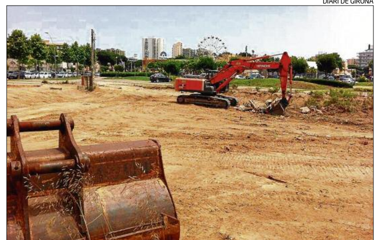
L'Ajuntament va enderrocar ahir el que quedava de Can Sureda.
