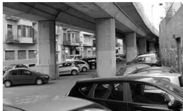
Vehicles aparcats sota el viaducte en l'espai que fins ara ocupava Adif per necessitats dels veïns o l'obra ■ D.V.
