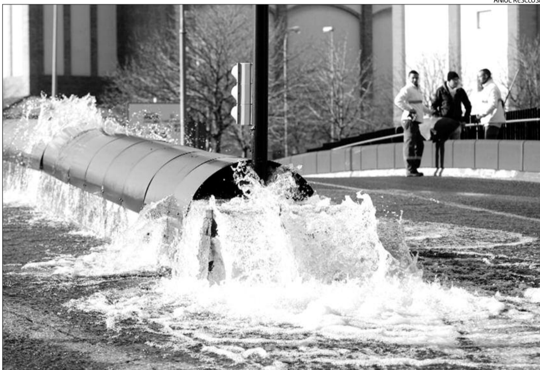
La canonada rebenca vessant aigua al pont que enllaça el carrer del Carme amb la plaça Països Catalans.
