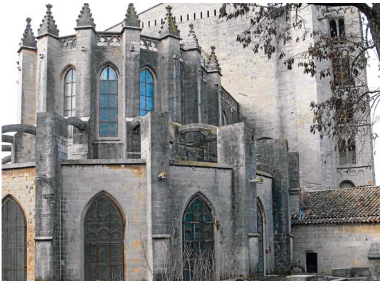
Una vista de la façana est de la catedral de Girona, amb l'absis gòtic, que necessita ser restaurat ■ ANNA PUIG
