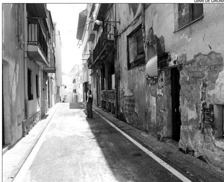
El carrer Vista Alegre amb la marca vial de prohibició pintada al carrer.
