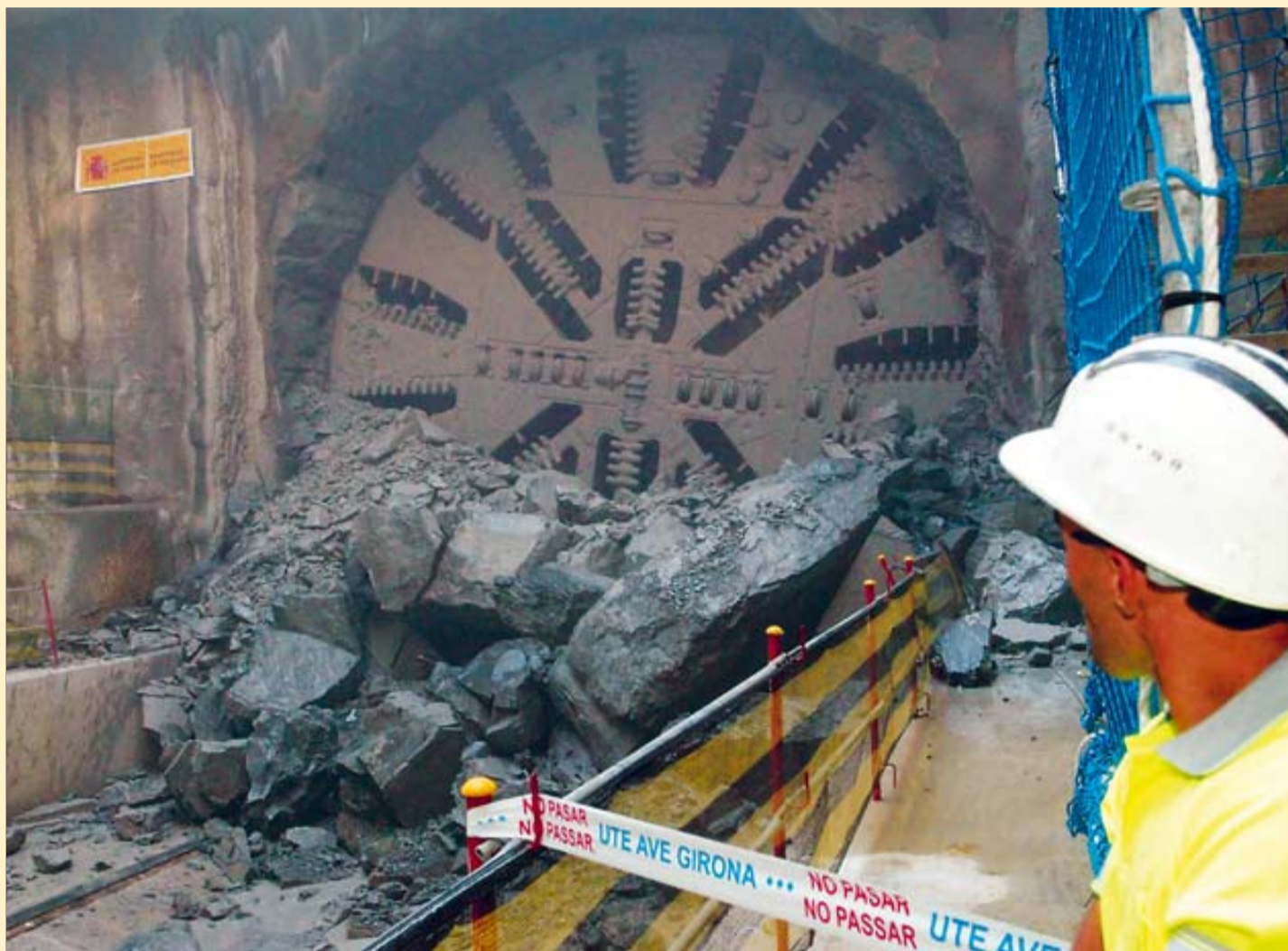
Un treballador observa com la 'Gerunda' forada l'últim tram de roca ■ JOAN SABATER
