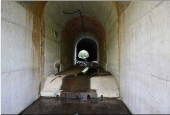
OD9: Viaducte d'Alou C-65 (enllaç Alou - Santa Cristina d'Aro). PK 8 + 250
