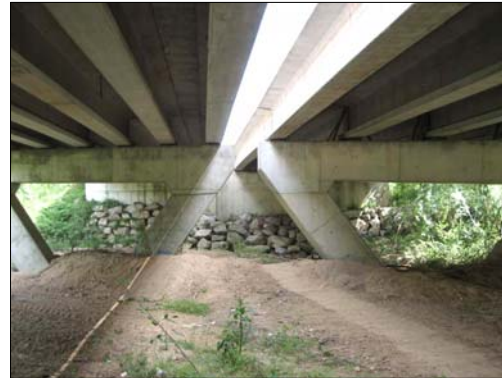
OF 2: C-65 Viaducte sobre el riu Ridaura PK 3 + 487 a PK 3 + 535
