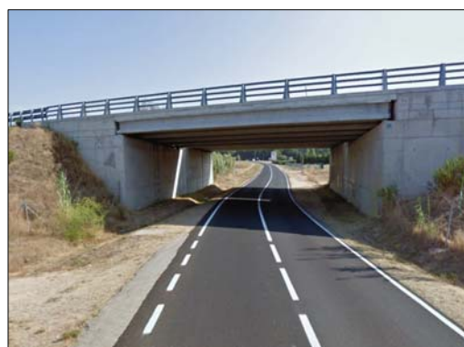
OF 1: C-65 - Pas carretera de Solius, GI6611 PK 4 + 617
