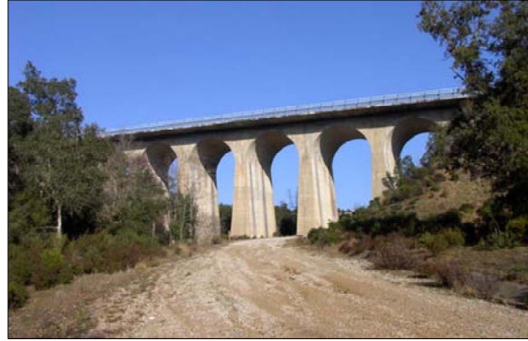
E2: Viaducte d'Alou C-65 (enllaç Alou - Santa Cristina d'Aro). PK 9 + 020 a 9 + 130
