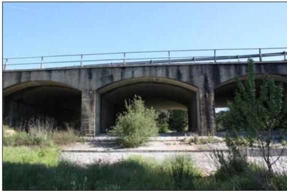
OD2.1: Viaducte de la riera Salenys C-65 (enllaç Alou - Santa Cristina d'Aro). PK 5 + 910 a 5 + 940
